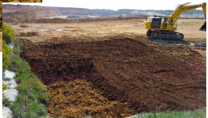
Figure 3. Mise en œuvre d'un pilote d'essai sur le site
